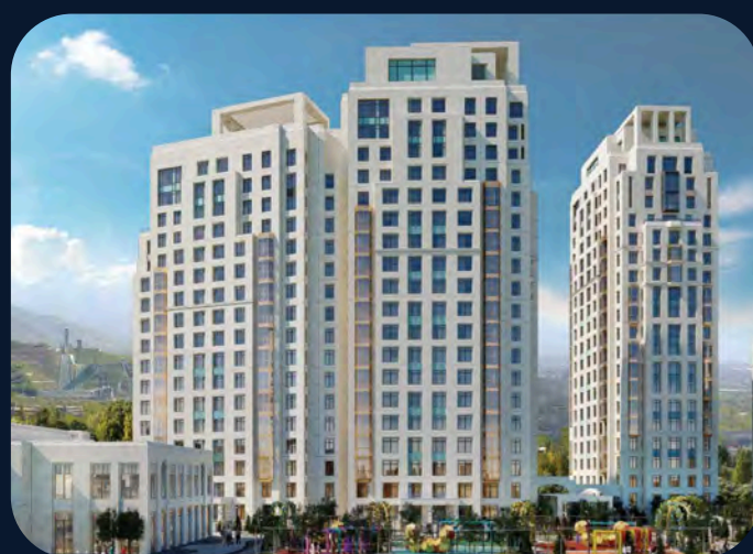
г. Алматы ЖК Central Avenue
