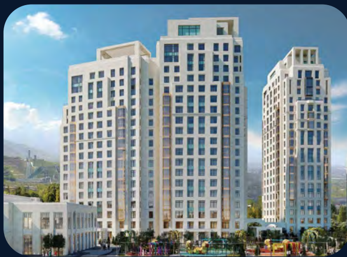
г. Алматы ЖК Central Avenue
