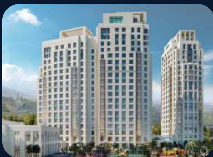
г. Алматы ЖК Central Avenue
